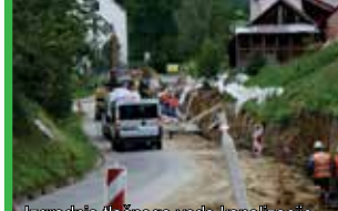
Izgradnja tlačnega voda kanalizacije
